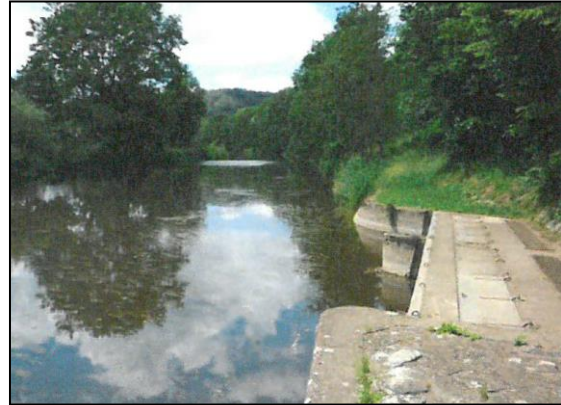
Zustand vor dem Umbau
