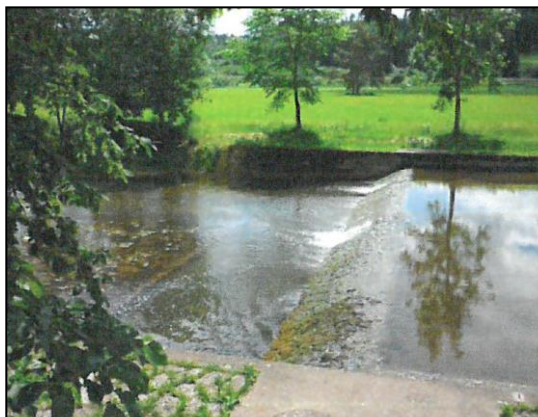
Zustand vor dem Umbau
